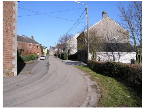
Photo 8 : rue de la Chapelle
