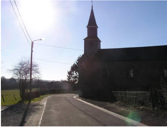
Photo 7 : Rue de la Chapelle
